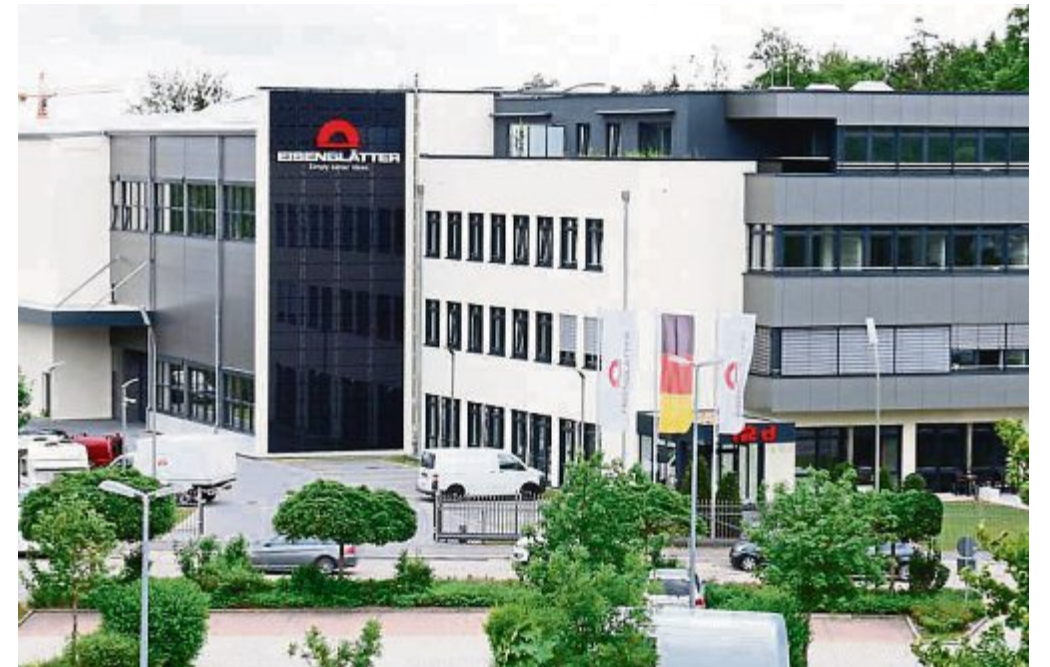
Neu und hochmodern: Zehn Millionen Euro investierte das Unternehmen in das Betriebsgebäude an der Jeschenstraße in Geretsried. Aktuell beschäftigt Eisenblätter 58 Mitarbeiter.
